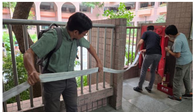
消防栓箱設備操作-拉水帶
