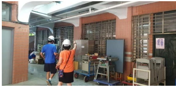
14_安全防護組前往校舍檢查確認建物有否安全暨回報現況_1
